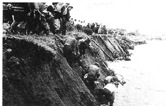
写真-1 水梨地区被災状況 (S.36.6洪水)
