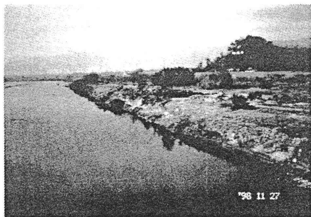
図-2 梁川橋から上流を望む。右側の洪水敷が調査対象領域である。
