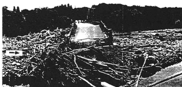
写真-2 高津橋の被災状況(栃木県土木部提供)
