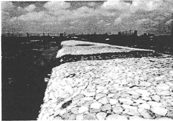
写真1 ニノ荒手越流部
