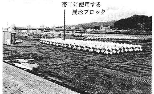
写真-2 水制工と帯工の施工状況
