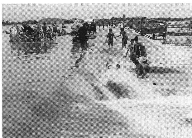
写真-1 6号線交差点手前での6A号線盛土の越流
