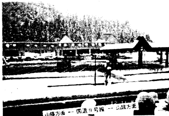
写真-1 駐車場（チェーン着脱場）の融雪状況
