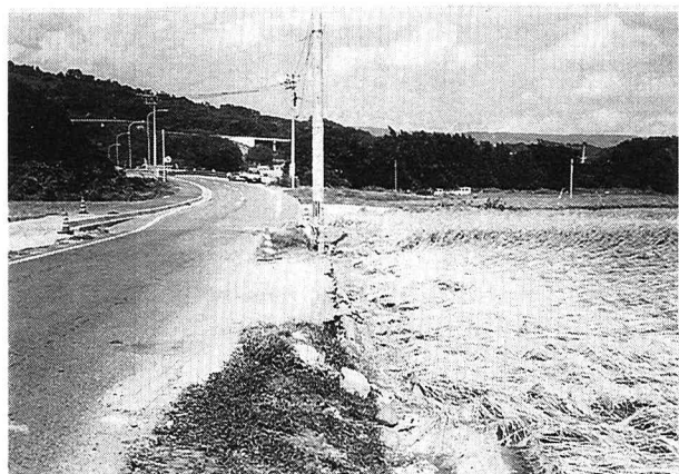
写真-13 八坂橋に続く県道上から下流方向への洪水流の痕跡
