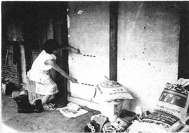
写真-6 大左右区の工藤 啓氏宅の土蔵についての水位痕跡 上部は1997年洪水、下部は1976年洪水時の水位痕跡
