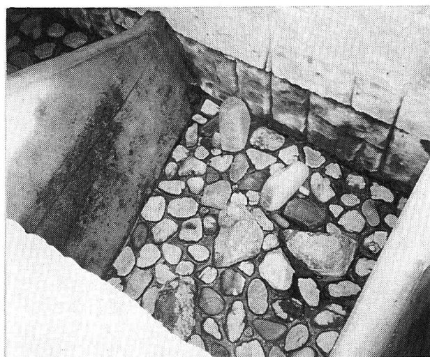
写真-4 全面に粗石を配置した状態
