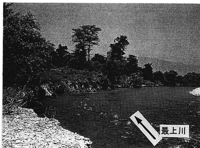
(a) 河岸の洗掘状況
