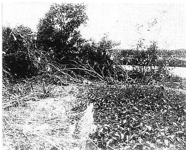
写真-3 倒木状況（米代川第4水制先端部）
