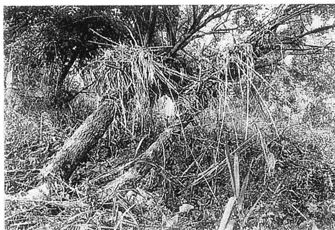
写真-5 水制部での倒伏（最上川，第1水制）
