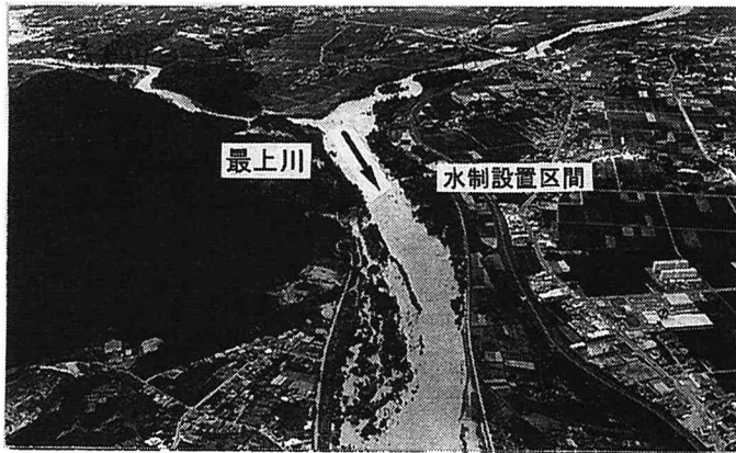
写真-2 柳水制設置区間の航空写真（最上川）
