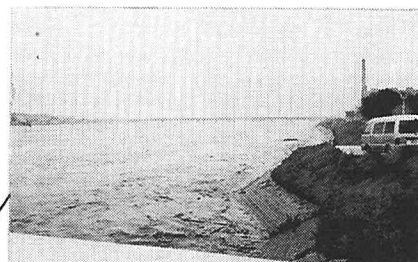
高角橋より下流を望む
