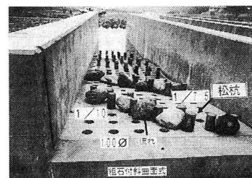
写真-1 魚道の構造
