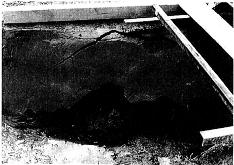
写真-3 洗掘、崩落の状況 (case B)
