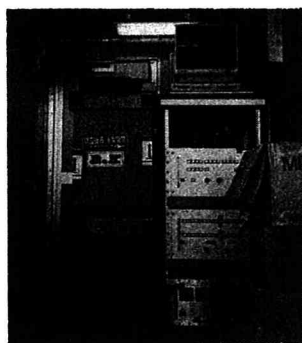
図-1(b) 短波海洋レーダ（コンテナ部）
