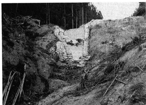
写真-1 下流側から見た長谷川堰堤
