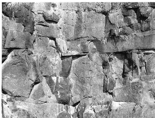
写真-1 原位置岩盤亀裂 (北海道登別市)
