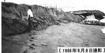
写真-4 河口左岸の状況
