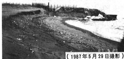
写真-5 河口左岸の状況
