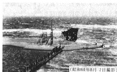
写真-3 河口砂州の伸長
