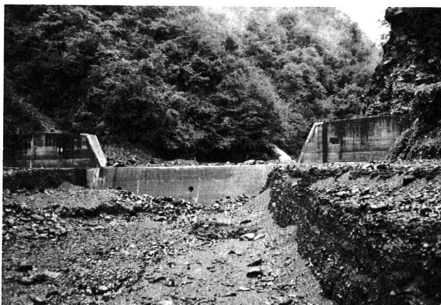
写真-2 稲又第2ダム付近の河床(1985年11月)
