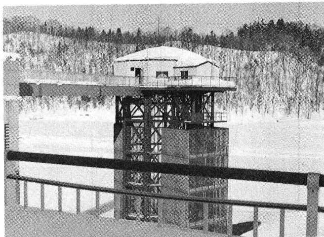
写真-1 取水塔全景
