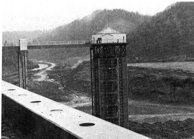
写真-3 工事中の取水塔
