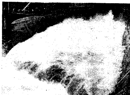
写真三 跳水型（富田発電所）
