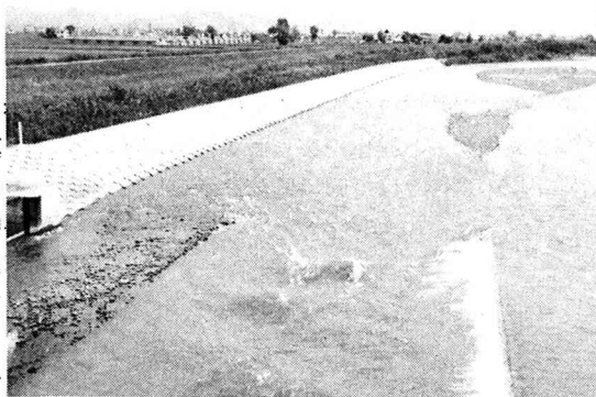
写真-5 忠別川第4頭首工土砂吐 水路上の堆砂 (S.55,9)
