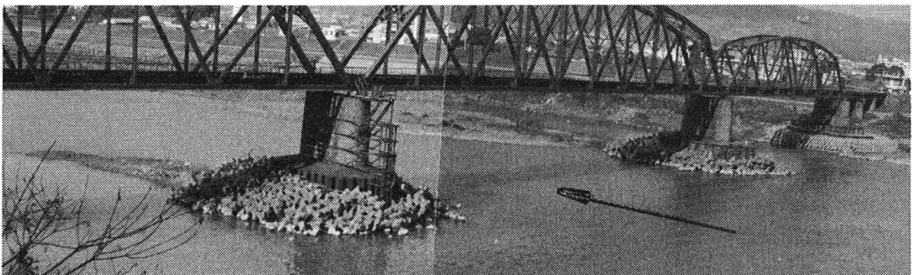
写真一 K川における橋脚保護工（K川は河床低下の大きい砂利河川である）昭和55年1月撮影
