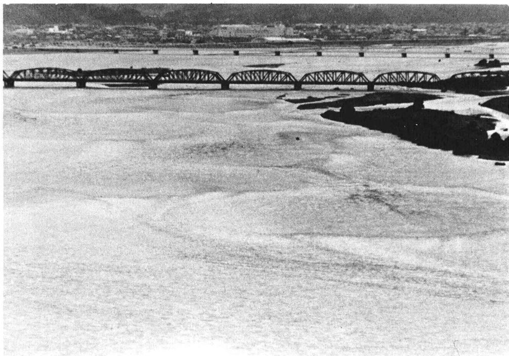
写真-1 大井川，昭・52.8.18. 18時 河床は殆ど全面濁水におおわれ，ウロコ状砂レキ堆の形成を示す波紋が明瞭に看取される。流量約 2,500 \text{m}^3/\text{s} ，（木下撮影） 鉄橋は東海道本線・先方は金谷町．
