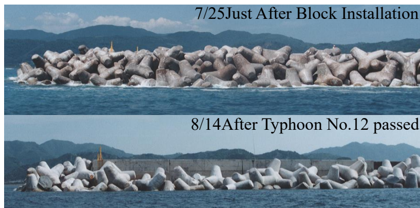
図-3.2 消波ブロックの沈下事例 12)
