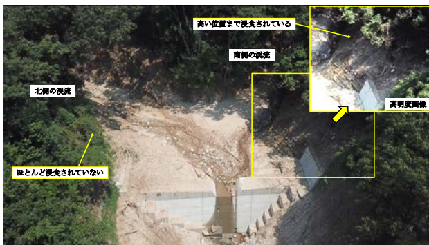
図-4 被災後の治山ダムの様子
