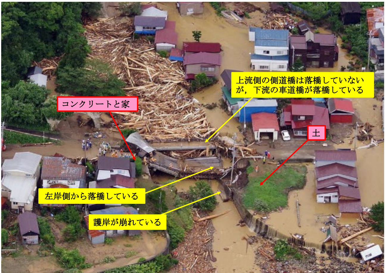
図-14 被災後の小赤川橋（撮影：アジア航測株式会社）
