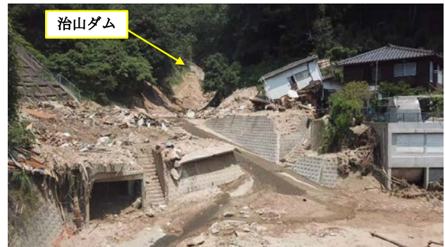
(a) 土石流が宅地に流れ込んだ地点の被災後
