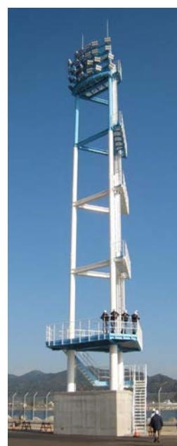
図-10 避難施設付き照明塔（静岡県清水港管理局提供）
