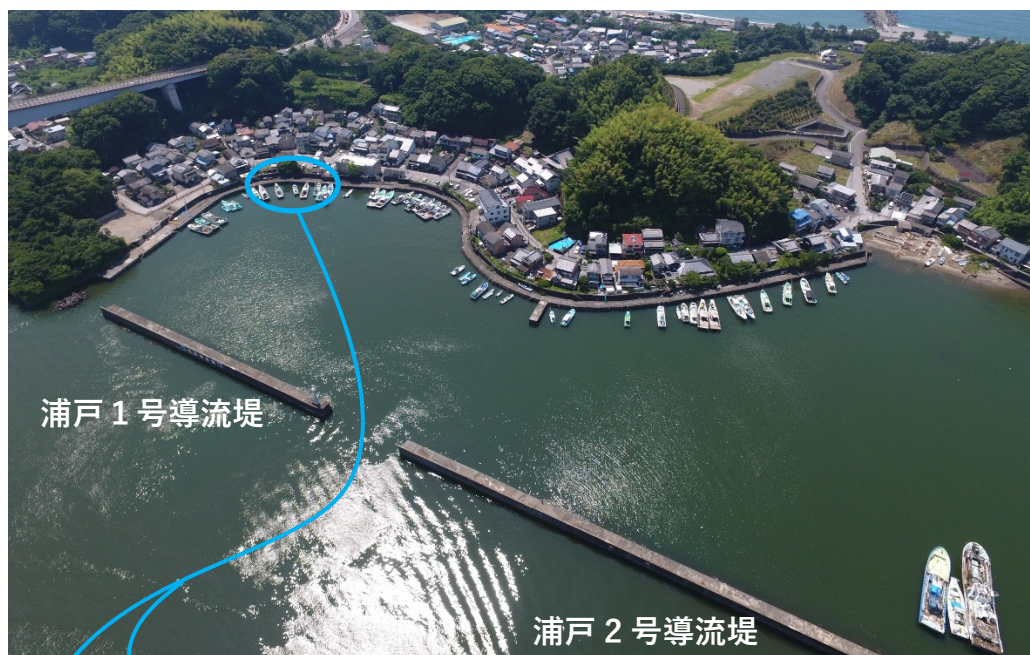
写真－7 浦戸地区の小型船だまり（第2ライン）
