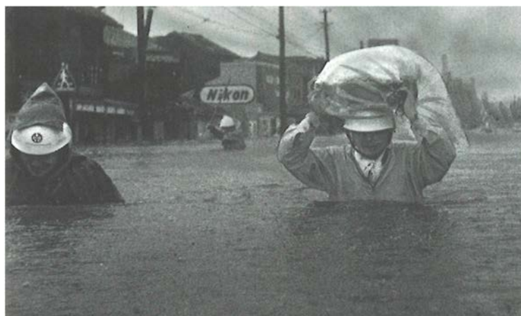
写真-1 高知市中心部の高潮浸水状況(1970年台風10号) 2)
