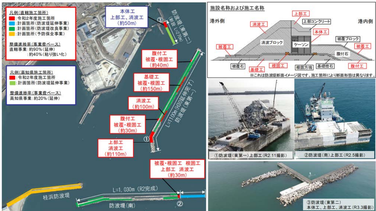
図-13 第1ラインの防波堤整備状況（港湾整備事業）
