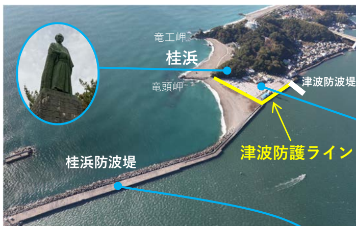
写真-4 桂浜公園の現状と防護ライン
