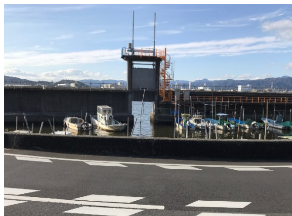
写真－9 開口部に水門を設けた船だまりの事例
