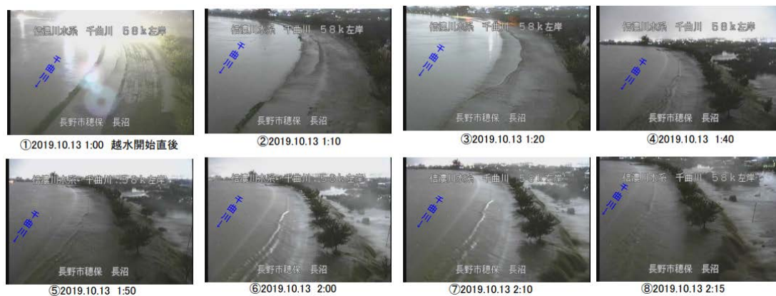
図 4 堤防決壊箇所に設置されたCCTVカメラによる堤防決壊前後の時系列変化（文献6）
