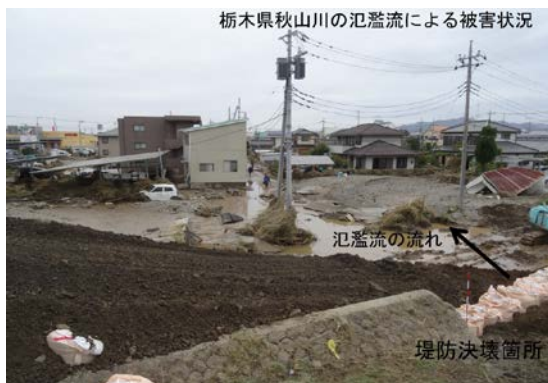
図21 台風19号による秋山川破堤による 氾濫被害（赤坂町右岸破堤）
