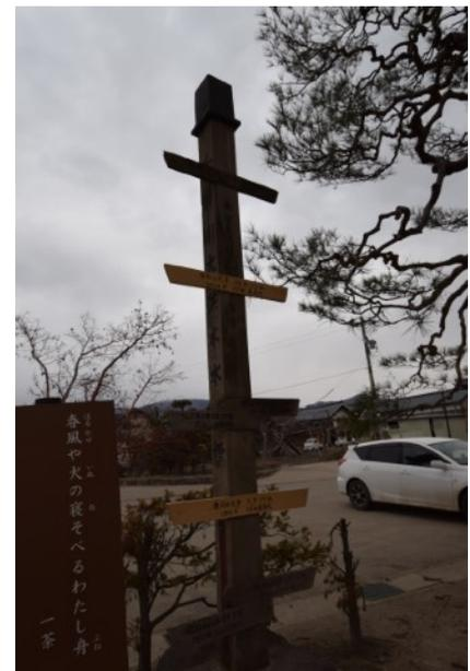
図-10 千曲川左岸堤防決壊地点の近くにある妙笑寺の水位票 上から1742年、2019年洪水。それ以外にも1896年、1910年など他地域でも災害になっているものが少なくない
