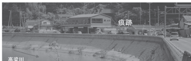
図 4.12 備中広瀬駅付近の国道 180 号線の浸水状況
