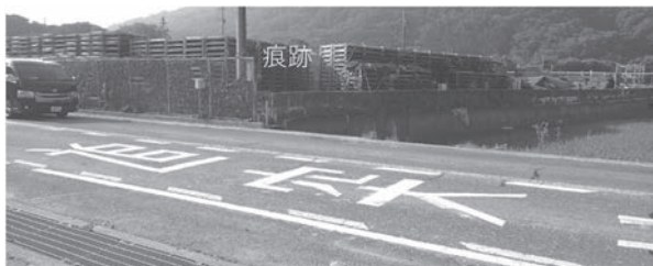
図 4.9 日羽の国道 180 号線の浸水状況
