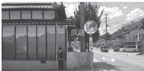
図 4.14 落合町(榎)阿部地区の浸水深 2.8 m の状況
