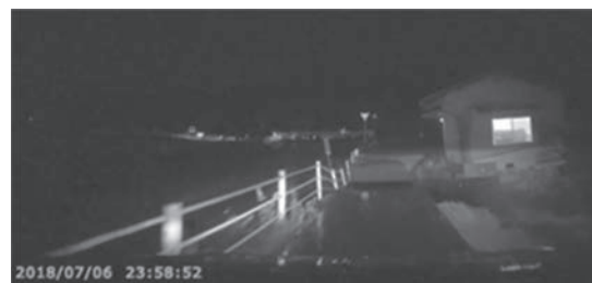
図 3.9 高馬川右岸の決壊直後の状況
