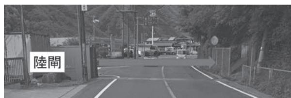
図 4.15 落合町阿部地区の陸閘の状況
