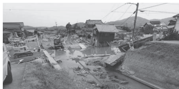
図 3.15 末政川 0.7 km 付近の兩岸決壊箇所の状況
