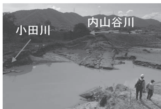
図 3.11 小田川 6.4 km 左岸の決壊状況
