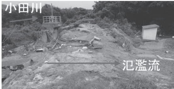
図 3.19 真谷川 0 km 右岸の半壊状況
