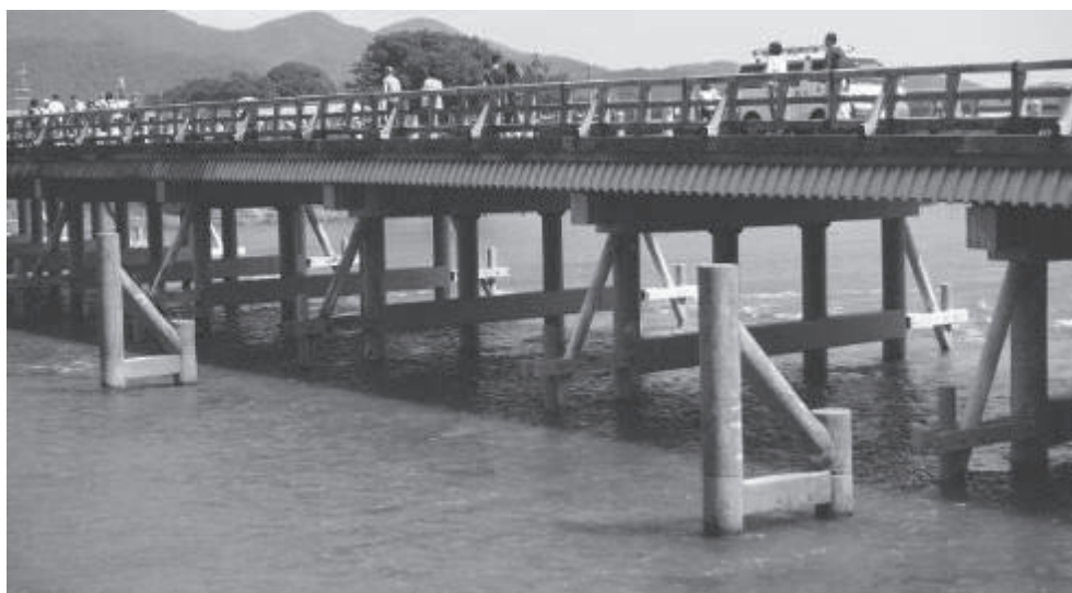
図-8 木除杭の設置状況（京都嵐山；渡月橋） 10)
