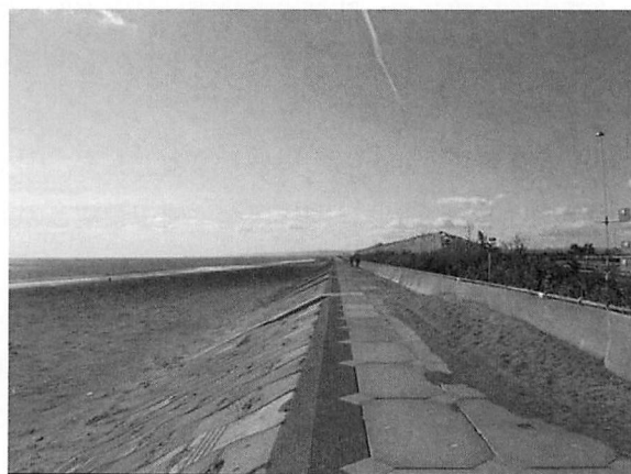
図5 宮城県岩沼市の防潮堤
