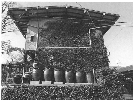
図-15 あめにわ憩いセンターの外観 甕にも雨水が貯留されている
