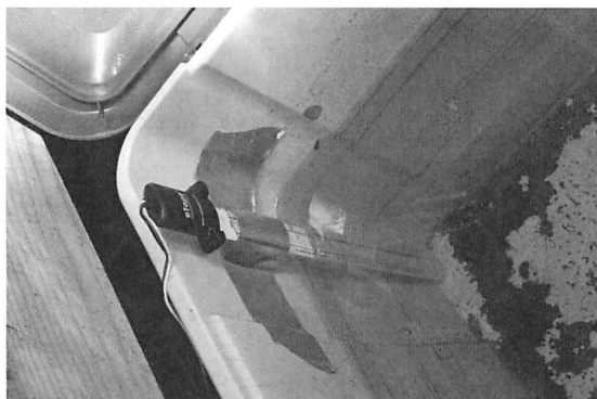
図-16 あめにわ憩いセンターの雨水タンクに設置したeTape
