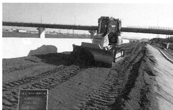
写真-6 MCブルドーザーによる土の敷均し
