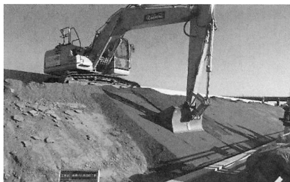
写真-5 MCバックホウによる切土法面整形
