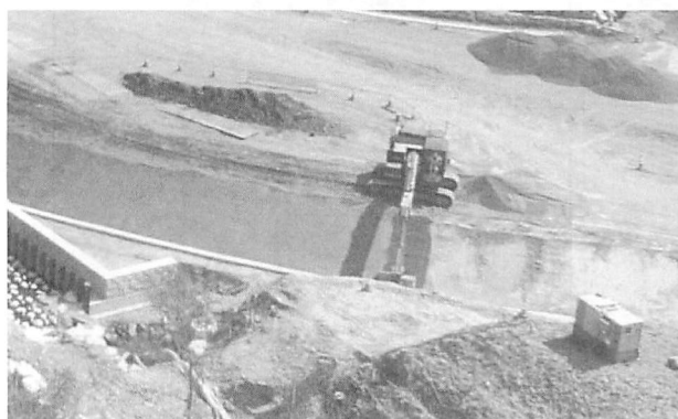
写真－3 ICT建設機械を用いた法面整形
