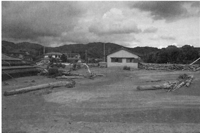
写真-2.6 北川下流域の土砂・流木被災
