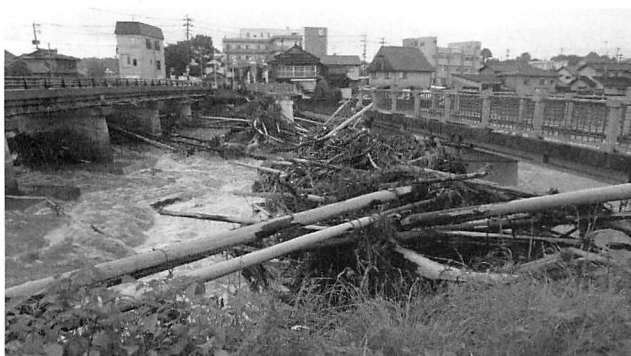
写真-2.3 合志川の橋梁の流木被災
