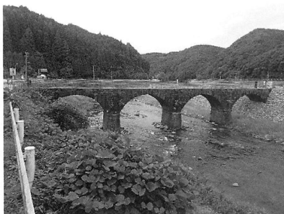
写真-4.2 宮ヶ原橋 (2017年撮影。橋桁上部は工事中。)
