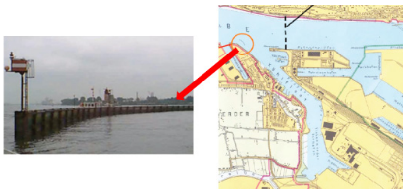
図-21 河川港(ドイツ・ハンブルグ港)の掘り込み泊地入り口に設置された水流制御型の埋没対策構造物 (21)
