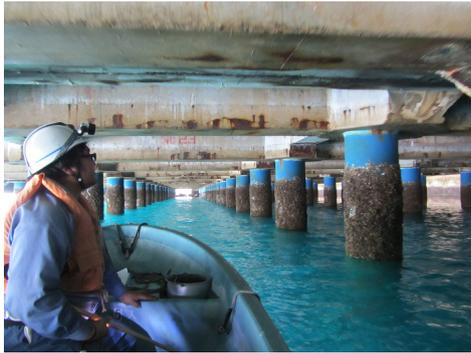
写真-1 栈橋上部工の点検診断
