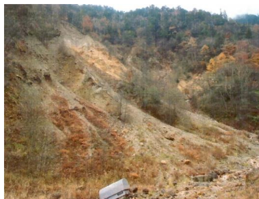
写真-2 凍結融解により生産された土砂により形成された崖錐（山野井，2017）
