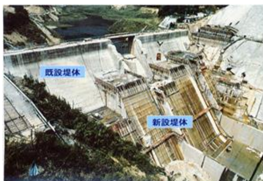
図－22 堤体嵩上げの例 1) (萱瀬ダム)
