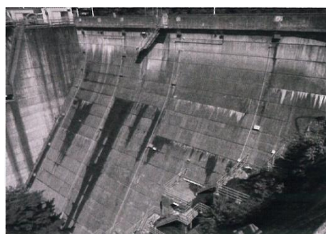
図-20 漏水が認められたダム（写真）での衝撃弾性波を用いた堤体内部（打継面）の調査 18)
