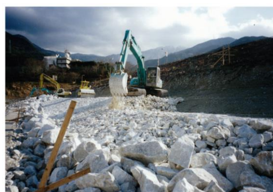
図-16 フィルダム上流面の補修工事状況 1)
