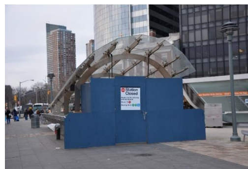
写真3 2012年10月のハリケーン・サンディ被害で閉鎖された地下鉄入り口
