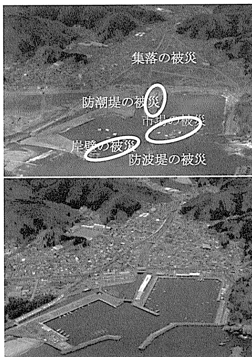
写真－5 田老漁港（上：被災後、下：被災前）
