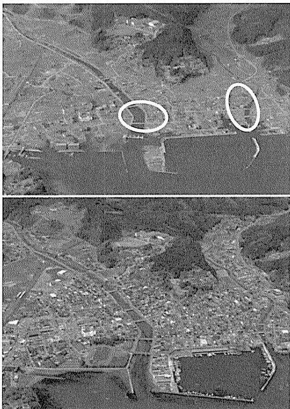
写真－８ 志津川漁港（上：被災後，下：被災前）
