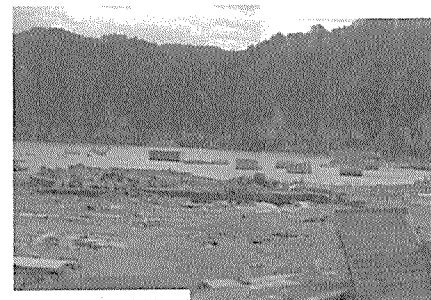
防波堤、護岸等被災
