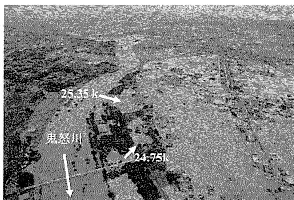
図 2 5 若宮戸地区の溢水状況の斜め航空写真 (9 月 10 日 15:07 撮影, 国交省関東地方整備局提供 13) )
