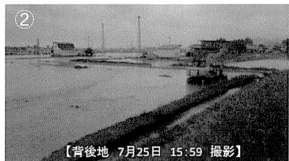
写真-14 堤防決壊箇所の背後地の浸水状況
