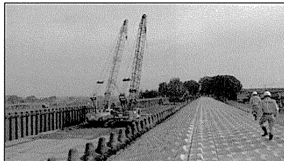
写真－4 堤防決壊箇所の応急復旧完了状況
