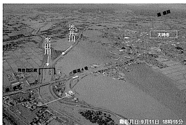
写真-8 支川渋井川（宮城県大崎市）からの氾濫状況
