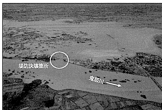
写真－2 茨城県常総市三坂町の堤防決壊状況
