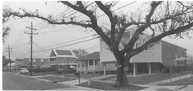
写真3 ニューオーリンズ郊外のピロティ形式の再建された住宅 (床の高さが家ごとに不揃いとなっている)
