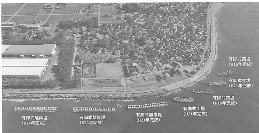
写真1 生地鼻の有脚式離岸堤と突堤群（国土交通省黒部河川事務所提供）
