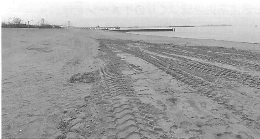
写真4 ニューヨーク・スタッテン島の養浜による浜の嵩上げ
