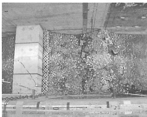
図-23 実験後の状況(水位差約 0.6m)
