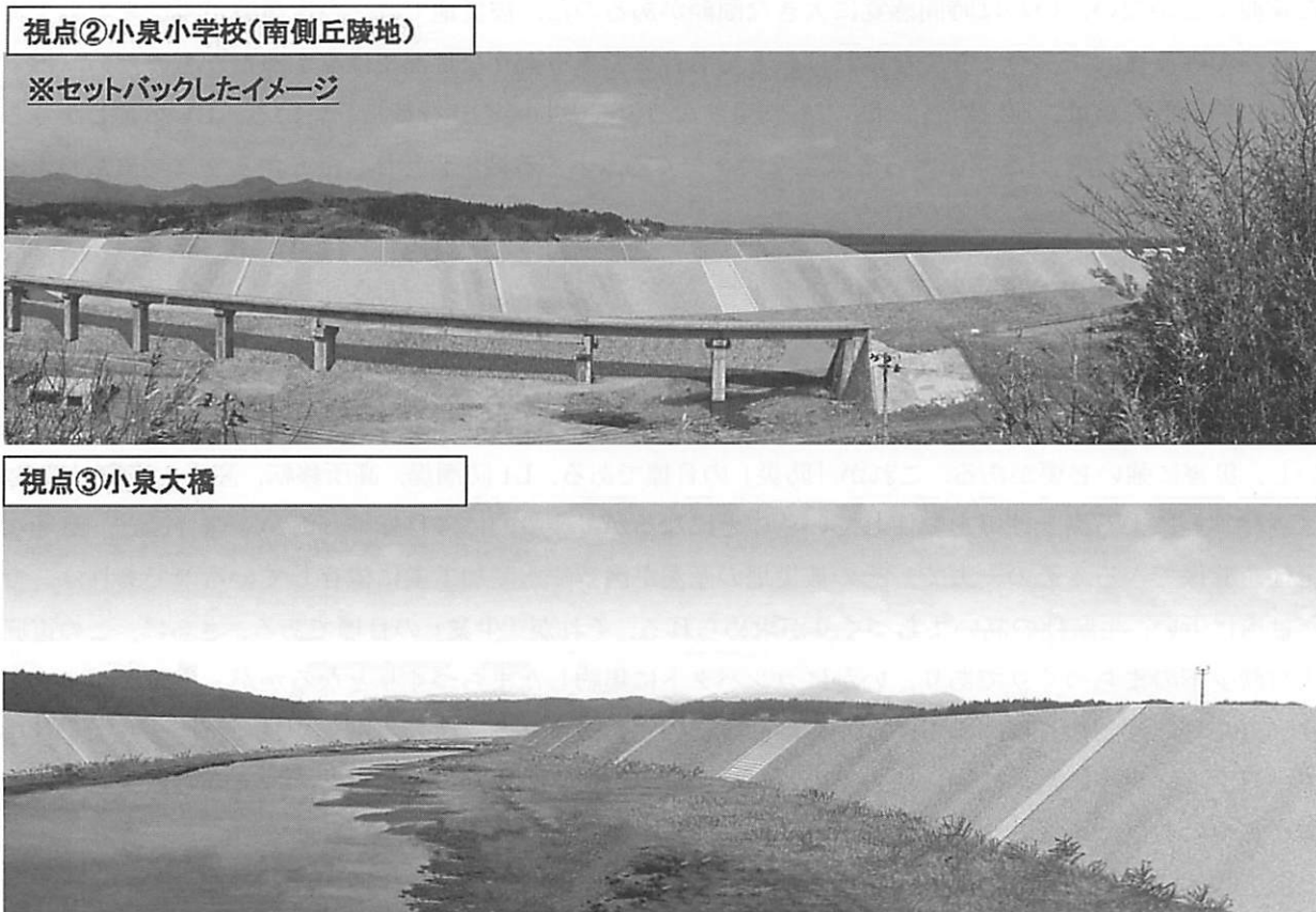
図 1 気仙沼市津谷川背水堤のフォトモンタージュ 出典：第 2 回三陸南沿岸・石巻海岸地区環境等検討懇談会資料 http://www.pref.miyagi.jp/soshiki/kasen/keikan.html
