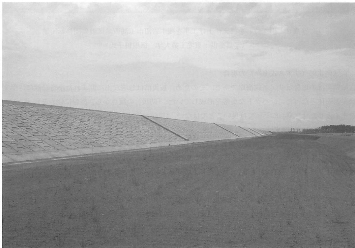
写真1 完成した仙台南部海岸防潮堤
