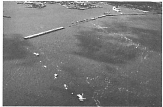
写真-2 津波で被災した八戸港の沖防波堤
