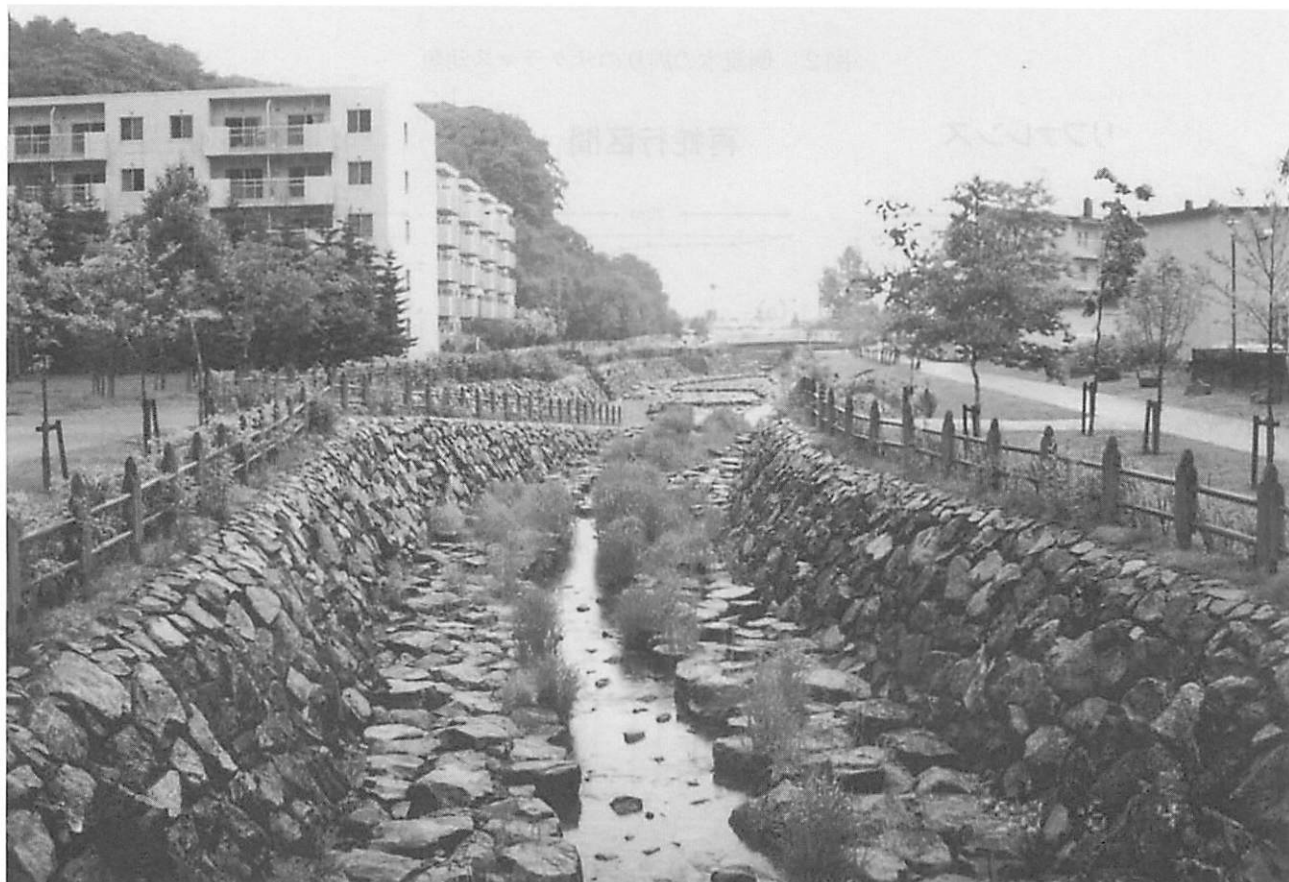
図4 石張り護岸の多自然型河川改修
