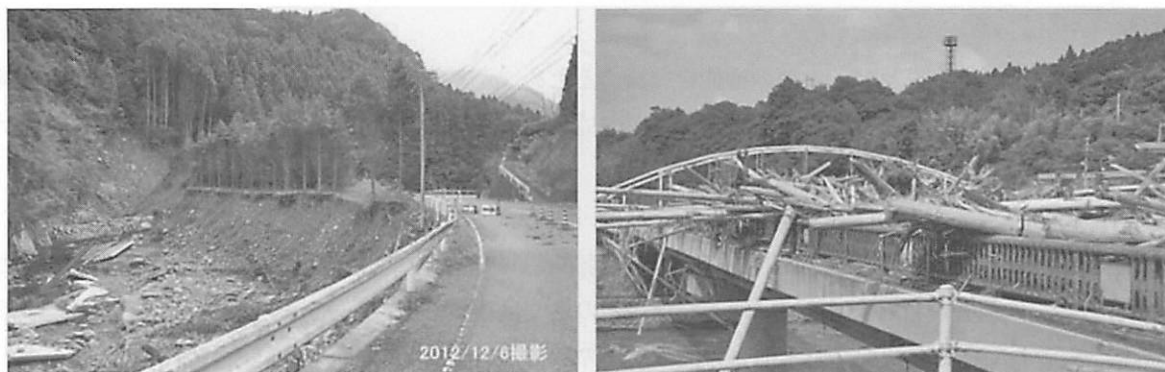
写真-3 九州北部豪雨の被災状況 (左：流木流出 (筑後川水系高瀬川)，右：流木集積 (玉来川)) (矢野 2014)
