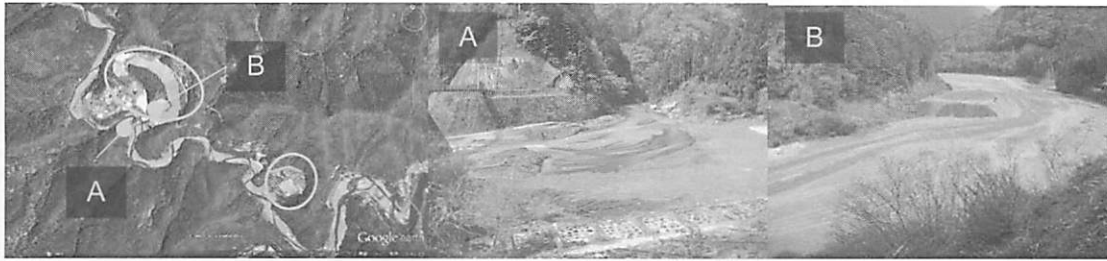
写真-4 二津野ダム堆砂の除去と土地の造成
